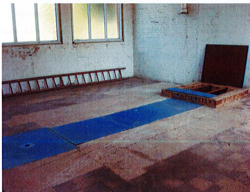
Photographie 3 : Tête du forage 00492X0207/F (source : Antea Group)
