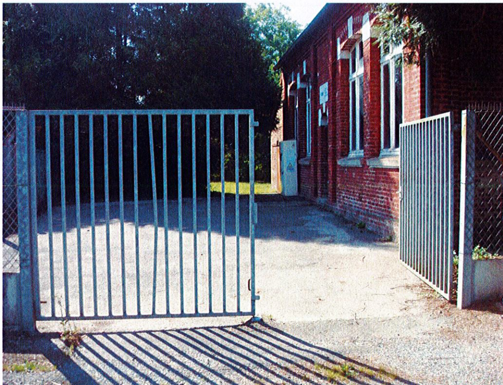
Photographie 1 : Accès au local technique (source : Antea Group)
